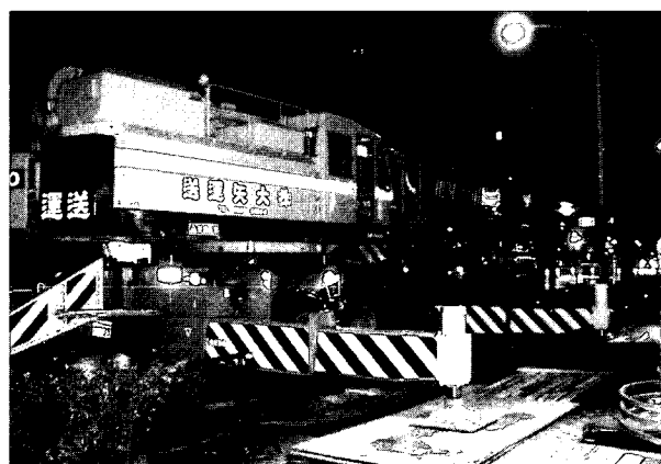
図5 大型機器搬入用160tクレーン
