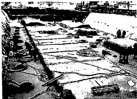
51本の鋼管基礎杭を敷設後に内部に水を充填して2本のポリエチレン製Uチューブを挿入
