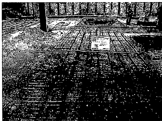
図6 地中熱採熱配管
