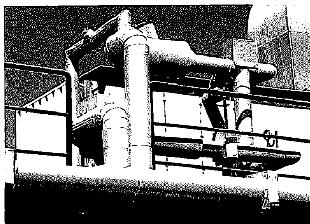
写真-5. ホテルの屋外塔屋に設置された外調機と冷水配管・三方弁 （Abu Dhabi市内：施工は地元施工会社）
