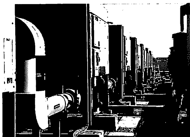
写真-4 ショッピングセンター屋上の空冷チラー（能力200USRt×6台） （Dubai郊外：プラント施工は欧米系冷凍機メーカ）
