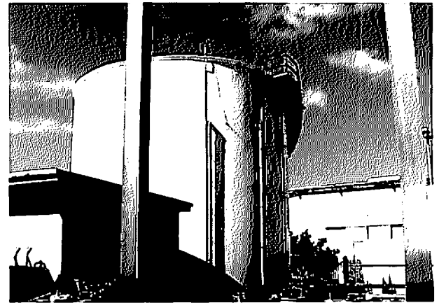
写真-6. 地域冷房プラントに設置された冷水蓄熱槽の例 (Dubai郊外)
