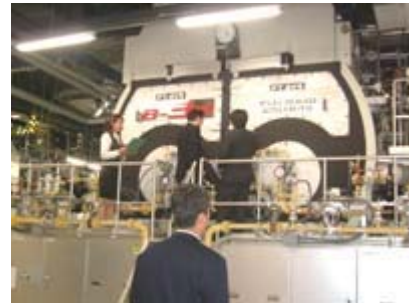
触っても熱くない 炉筒煙管ボイラー
