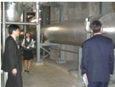
洞道の入口から 冷水配管を見る
