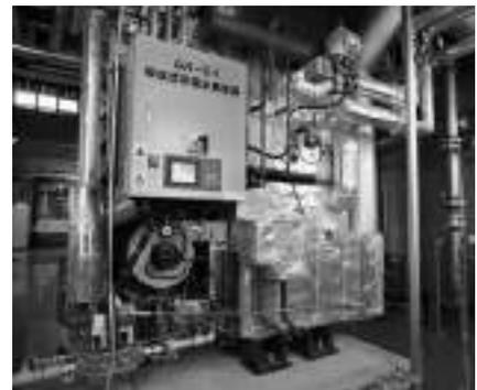
図8 排熱利用吸収式冷温水発生機
