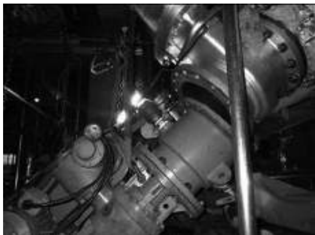
図8 活管分岐工法による導管分岐
