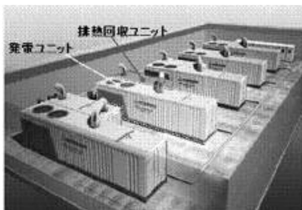
図4 7.5MW（1500kW×5台）コージェネプラント例
