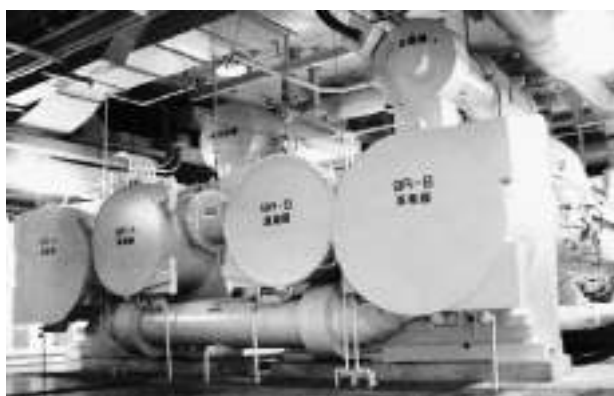
図5 更新後の電動ターボ冷凍機
