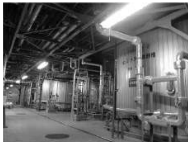
写真1 メタン発酵槽
