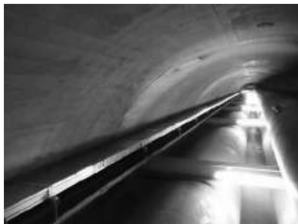
図11 送電ケーブル敷設状況
