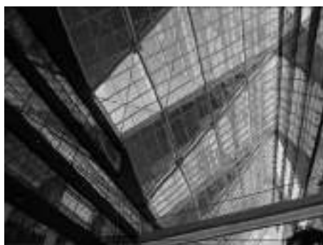
太陽光パネル
