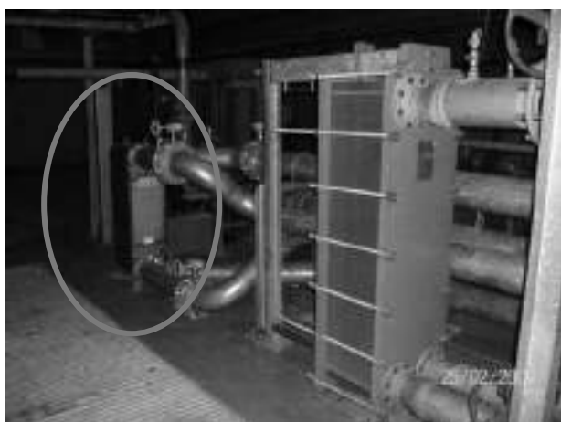
地域冷暖房にてガスケット式熱交換器から弊社ロウ付け式プレート熱交換器への置き換え実例 (写真奥が弊社製品B649タイプ)
