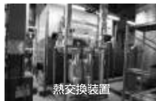
図7 循環ポンプ&タンク類
