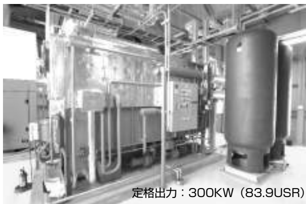
図6 吸収式冷凍機
