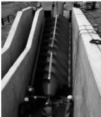
図7 らせん水車設置の様子
