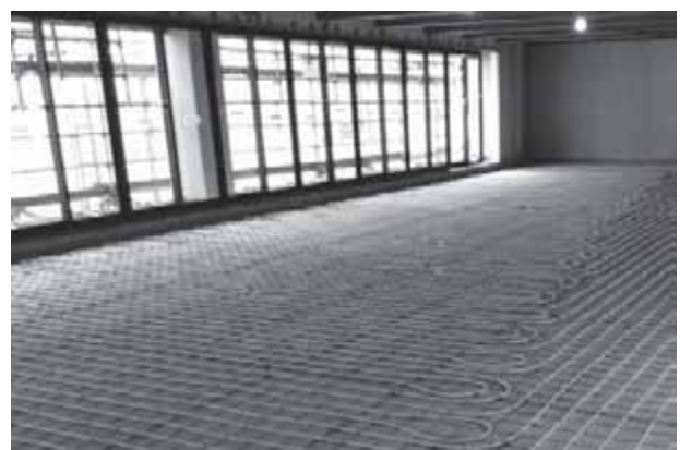
図8 躯体蓄熱用チューブの埋め込み
