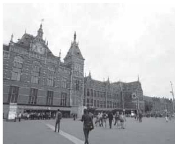
写真3 アムステルダム中央駅正面
