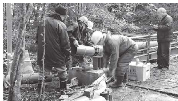
図10 地区住民による導水管敷設作業
