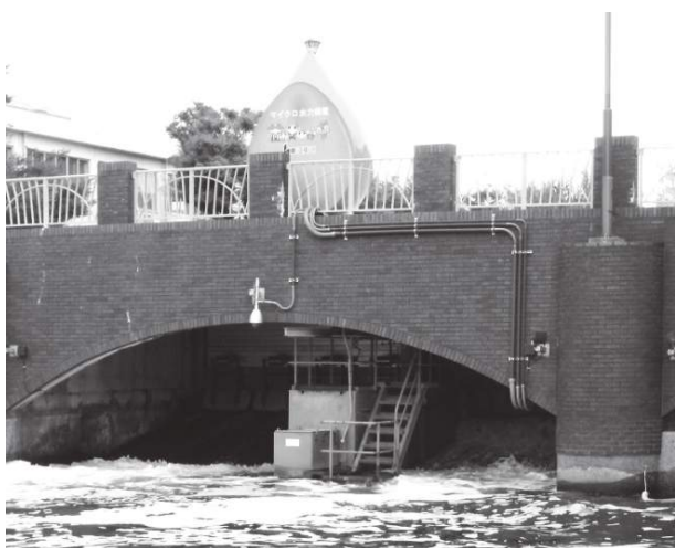
図11 橋の下の筐体が水力発電機
