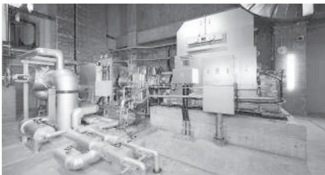
写真3 蒸気タービン発電機(ごみ発電)写真
