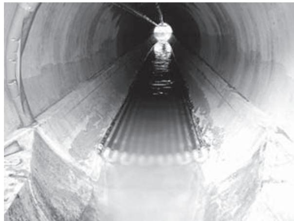
図9 下水管内熱交換器の例（管路底部設置型）
