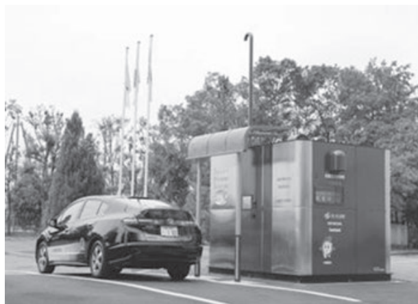
図4 小型水素ステーション（平成26年設置）
