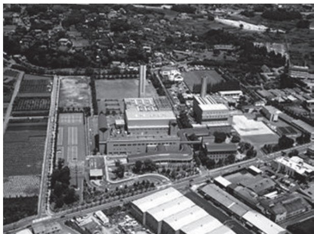
図3 ごみ焼却発電により計画停電の際にも稼働していた焼却場
