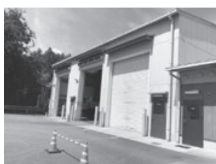
写真2 原料受入棟入口
