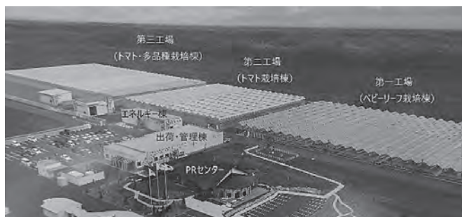
写真1 Jファーム苫小牧工場施設全景
