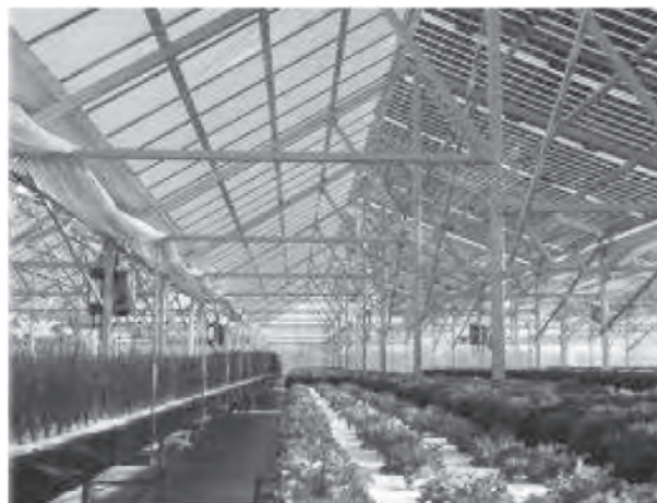
写真 モンゴル国で導入を進めているソーラーファーム
