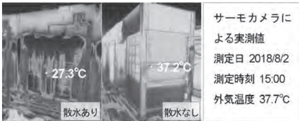
図7 サーモカメラによる屋外機表面温度実測
