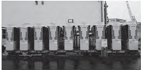
図6 MSV2の設置状況
