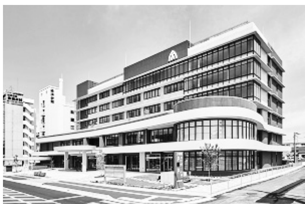
図4 大和高田市役所庁舎ZEB Ready
