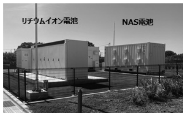
写真6 増設した蓄電池
