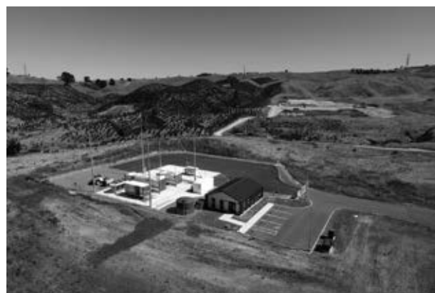
写真2 水素製造プラント
