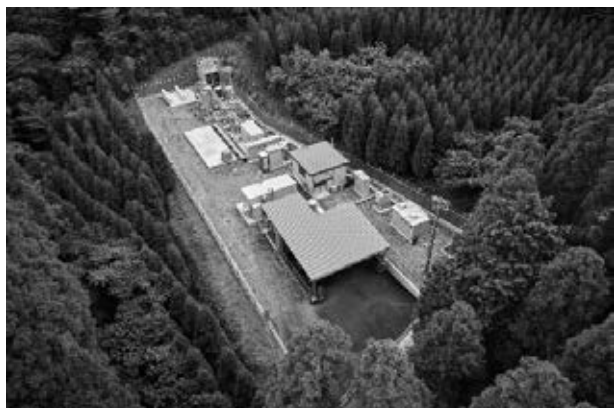
写真1 プラント全景
