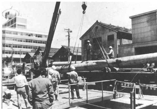
写真2 熱導管工事（1970年代）北海道熱供給公社所蔵
