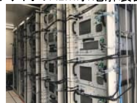
コンテナ内のAEM水電解装置
