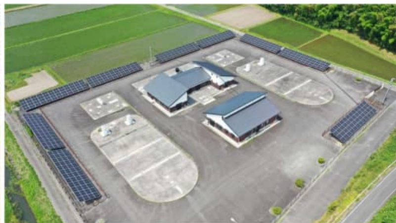
伯仙地区農業集落排水施設（179.28kW）
